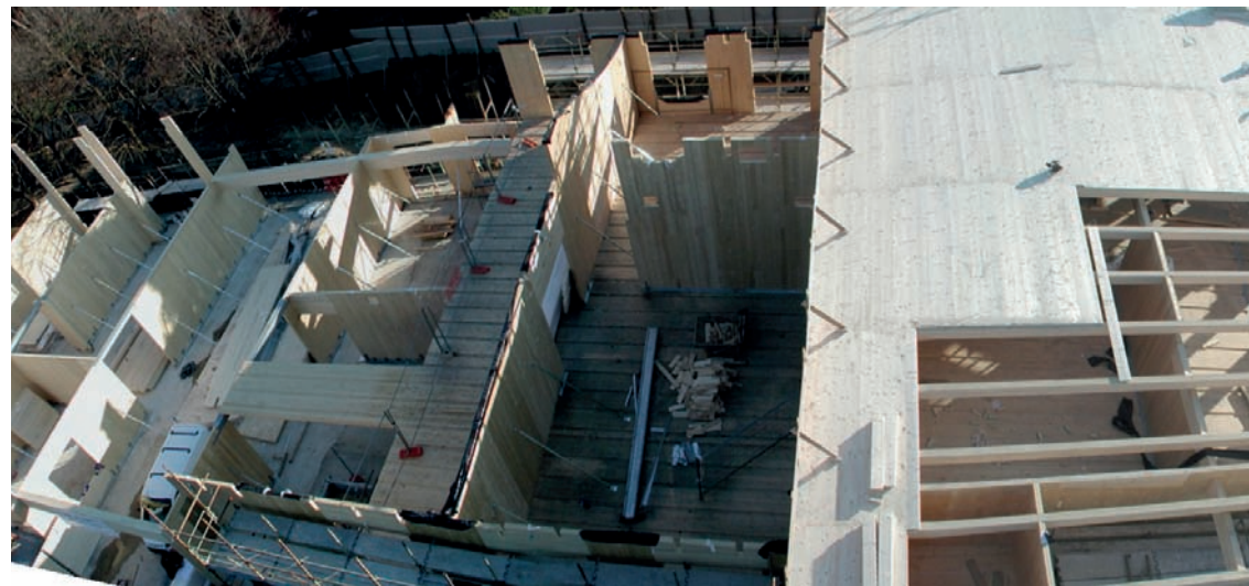
Fase di realizzazione della scuola Capuana: particolare della struttura interna in legno secondo le tecniche della bioedilizia
